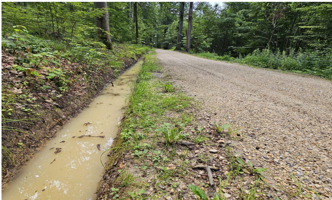
Entwässerungskanäle entlang von Maschinenwegen
